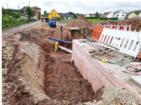
Bild: 103333: Abgabeschacht/Pumpwerk
