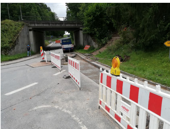
Bild: 104224: Bahnunterführung Richtung Langenloh
