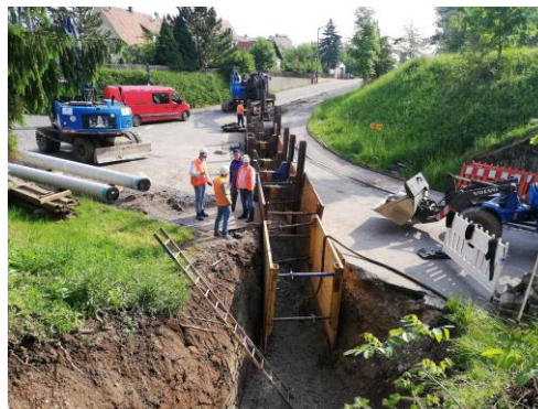
Bild: IMG_085218: Kreuzungsbereich Bahnunterführung
