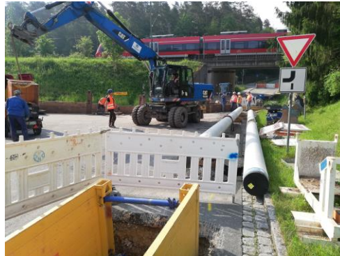
Bild: IMG_086440: Unterführung Bahn
