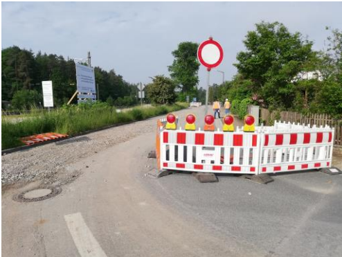
Bild: IMG_084717: Bahnhofstraße/Parkplätze
